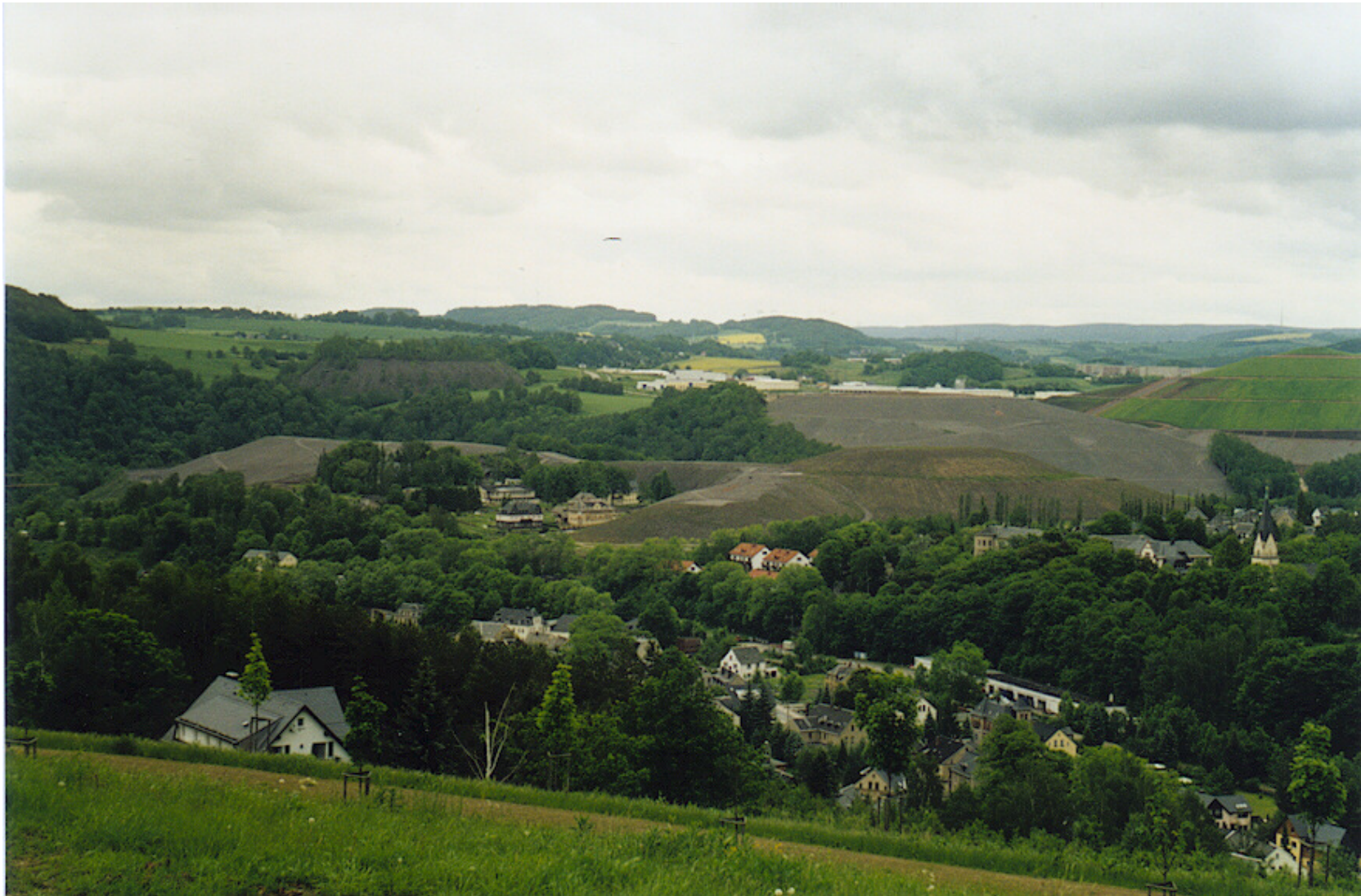
Halde 66/207 nach Profilierung und vor Abdeckung Mai 2002 / Schlema
