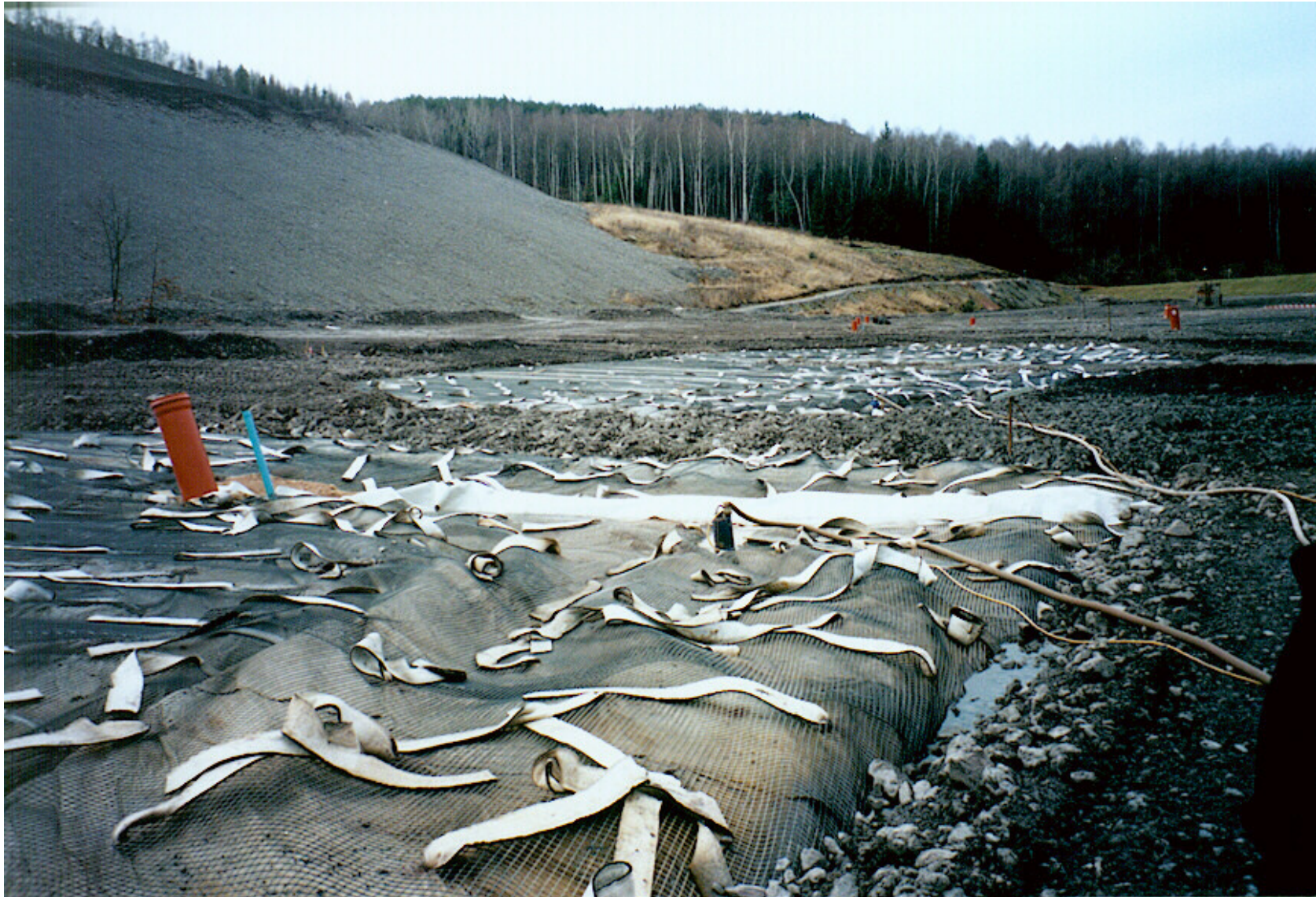
Zwischenabdeckung mit Geogitter und Vertikaldräns Februar 2001
