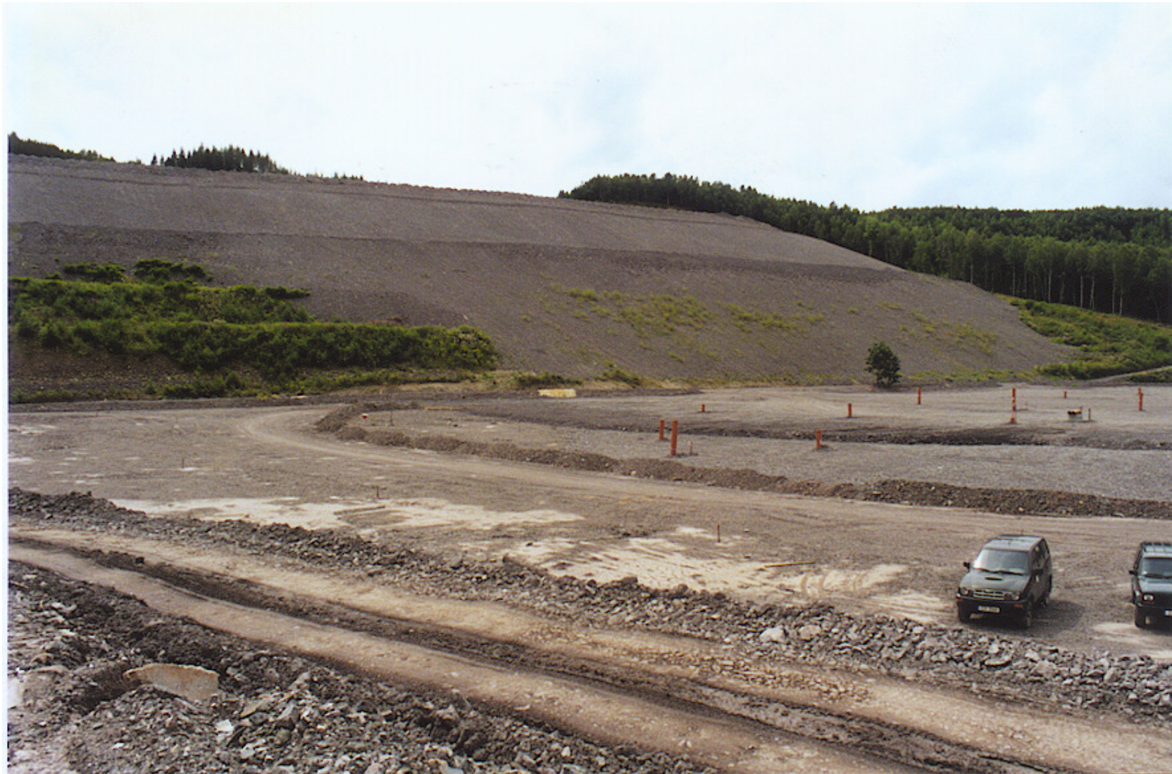
Absetzanlage Borbachtal / Schlema Herbst 2002
