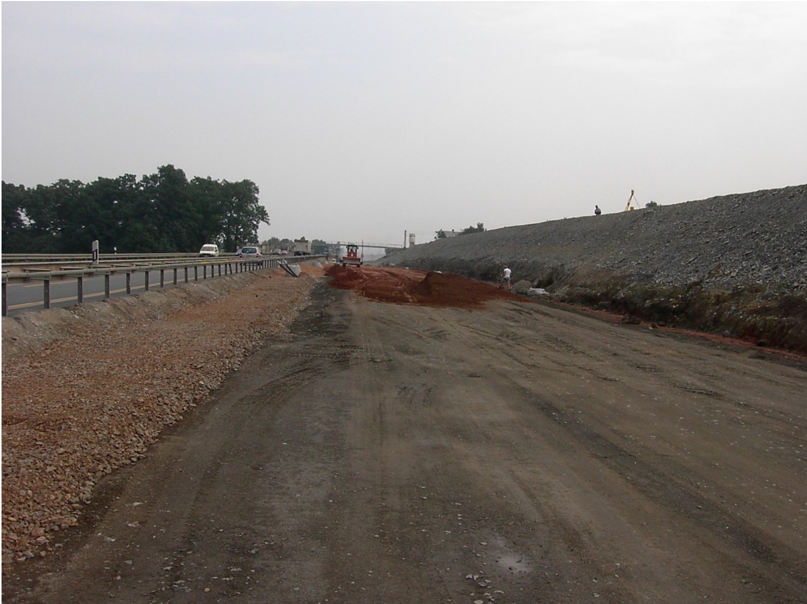
A 72, Chemnitz-Zwickau: Wiedereinbau von zementverfestigtem kontaminiertem altem Tragschichtmaterial
