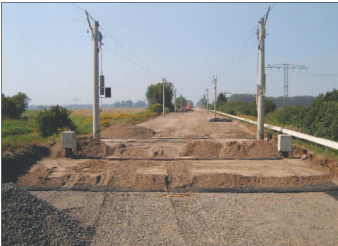
Bild 10 Einbau von Geogittern zwischen Paulineaue und Friesack (Quelle: DB AG)
