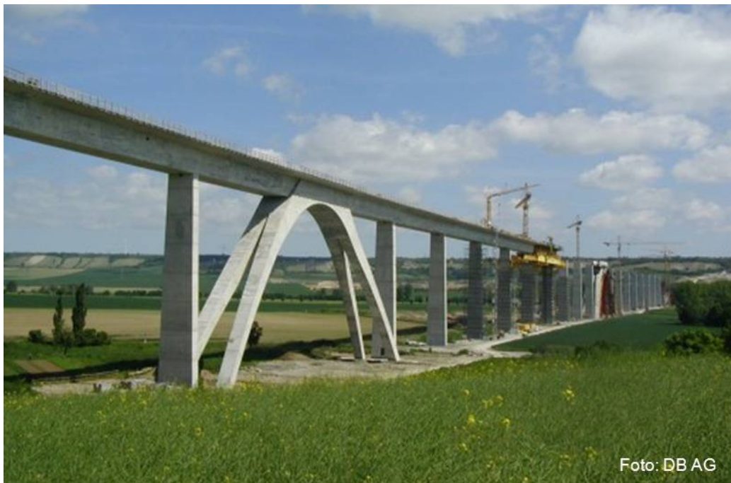
Abb. 1: Fertiggestellter Bogen der Unstruttalbrücke
