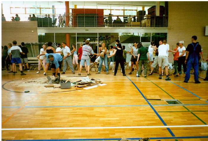
Tag 2 Nachmittag: Einbau Auflast (Sandsäcke), Piezometer-Einbau
