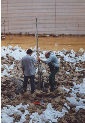
Tag 2 Nachmittag: Piezometer eingebaut
