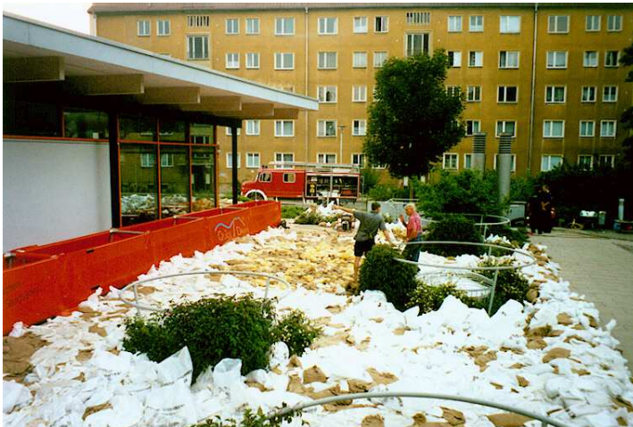
Tag 3 früh: Auflast auf Decke der Umkleieräume Sporthalle
