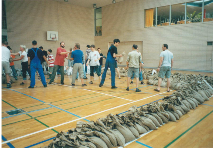
Tag 2 Nachmittag: Einbau Auflast (Sandsäcke), ca. 500 Personen
