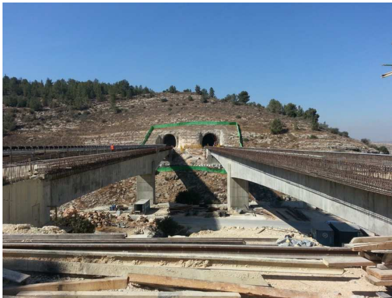
Abb. 5 Brücke Nr. 8 mit Blick auf Tunnelportal 2
